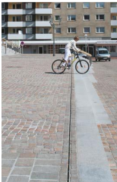
Příklady řešení štěrbinového žlabu
